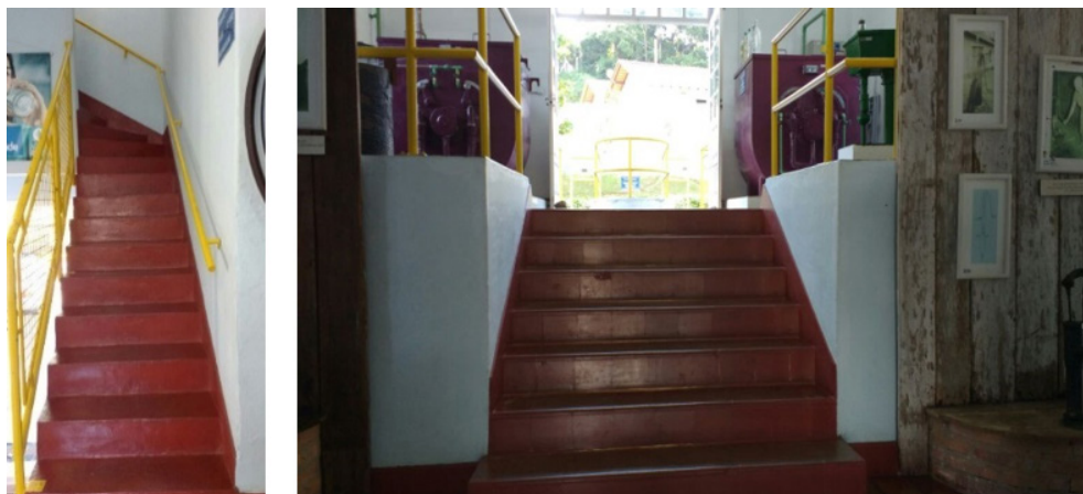
Figura 4. Escadas no interior do edifício
