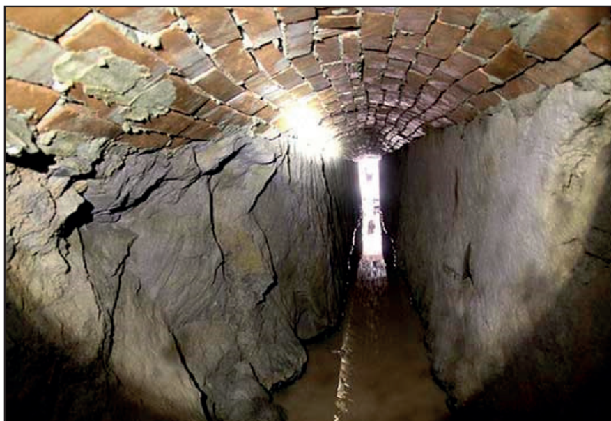
Figura 9. Interior do túnel
