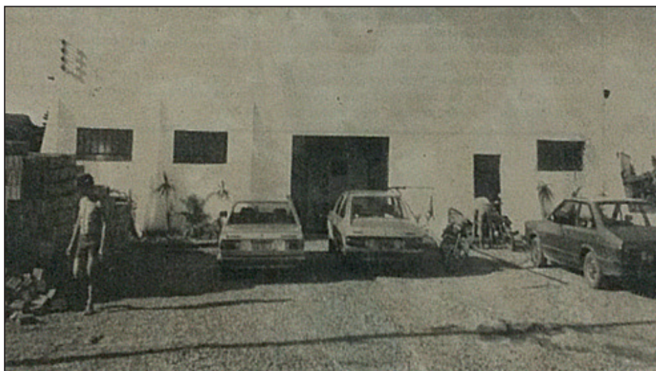
Figura 2. Sede do clube reformada em 1986
