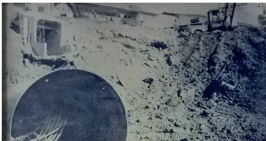
Figura 6. Obras de defesa da margem direita do Rio Itajaí-açu, nos fundos da praça Dr. Blumenau, vendo-se a desembocadura do novo canal (de concreto) do ribeirão bom retiro e o antigo tubo “Armco”
