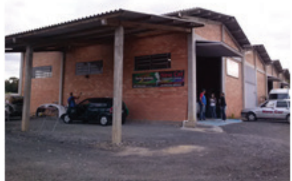
FIGURA 4 – VISTA PARCIAL DA EMPRESA NEW CAR CHAPEAÇÃO E PINTURA
