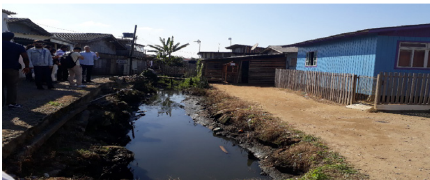
Figura 9: Vala construída entre as casas para escoar o esgoto doméstico
