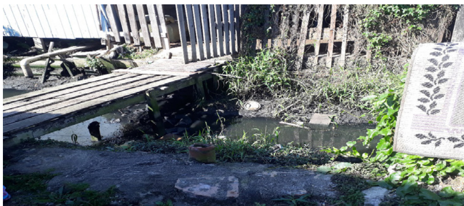
Figura 10: Pontilhão de acesso produzido pelo morador local
