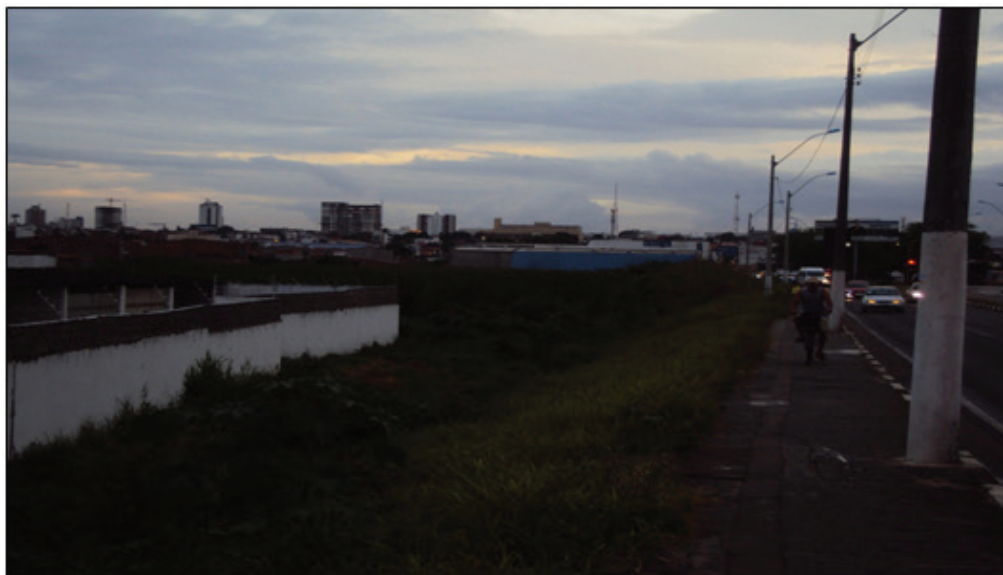
Figura 5. Ocupação irregular da Lagoa do Prato Raso e Avenida que separa as duas lagoas
