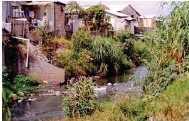
FIGURA 3 - RESIDÊNCIAS SITUADAS DENTRO DA ÁREA DE APP
