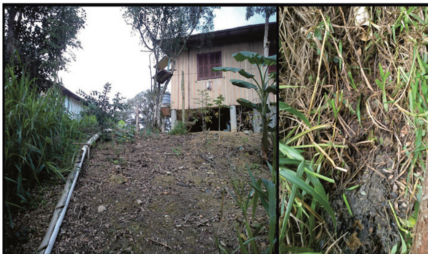
FIGURA 1 – DESPEJO DE EFLUENTES RESIDENCIAIS SITUADO NA RUA EDUARDO WIEDERKEHR EM BRUSQUE (SC)
