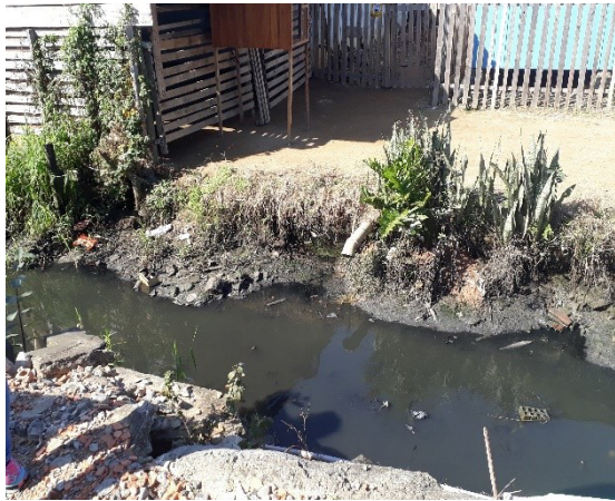
Figura 12. Esgoto sendo despejado na vala a céu aberto
