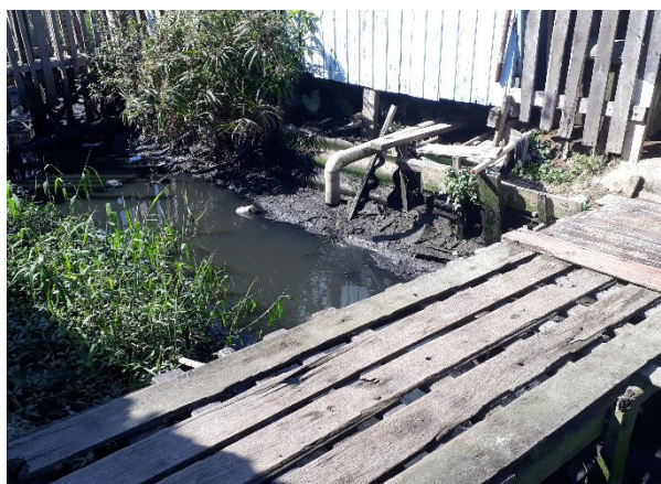
Figura 11. Esgoto sendo despejado na vala a céu aberto
