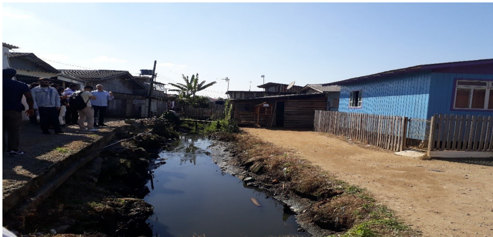
Figura 7. Vala construída entre as casas para escoar o esgoto doméstico
