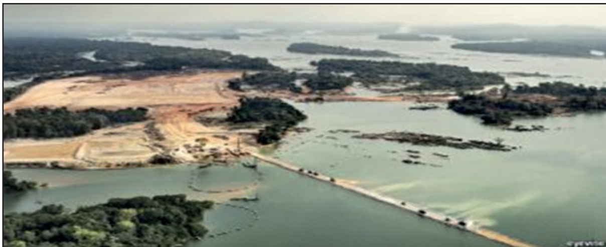
Figura 6. Foto construção usina Belo Monte - Rio Xingu - 2013
