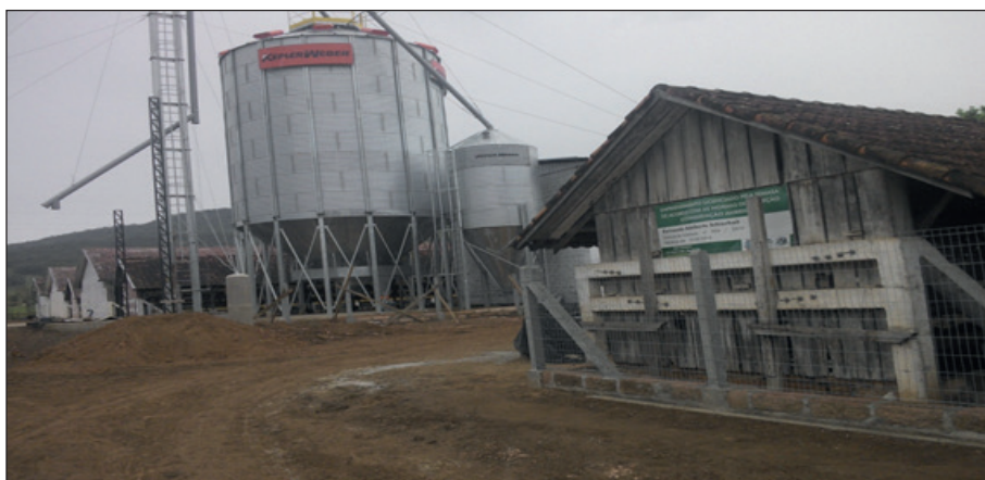
Figura 1. Entrada da propriedade com silos de ração ao fundo
