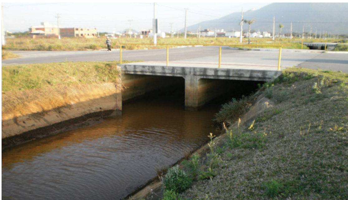
Figura 2. Exemplo de ponte para passagem de água para o manguezal
