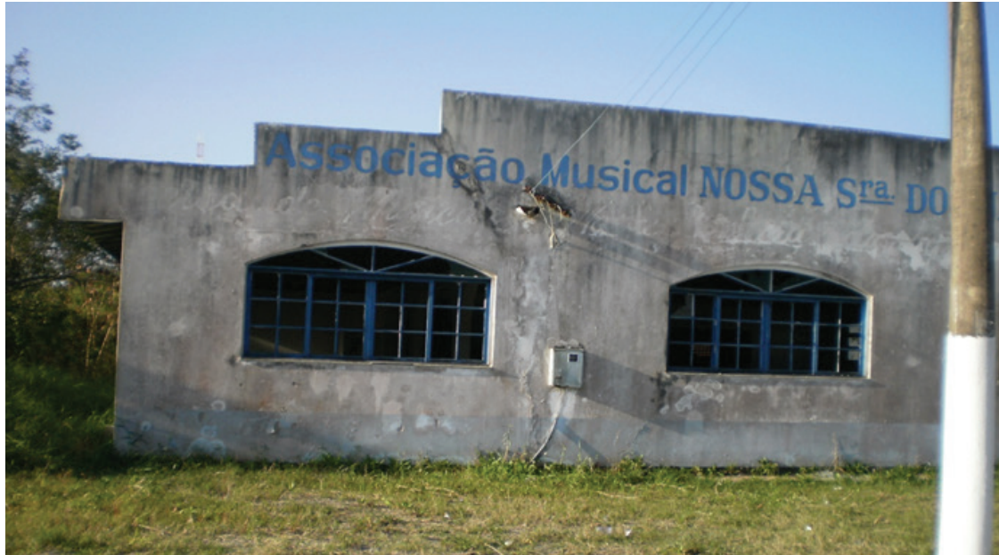
Figura 8. Construção de prédio em APP (manguezal)
