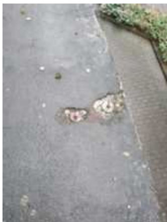
Figura 8 – Fixação de placa informativa
