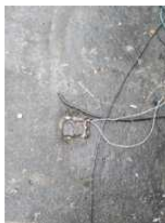
Figura 9 – Passagem de fios
