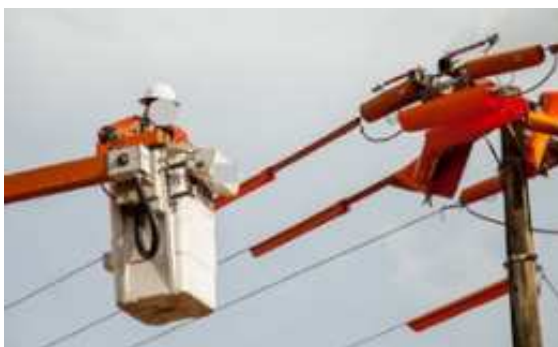
Figura 1 – Eletricitista realizando manutenção em rede de alta tensão
