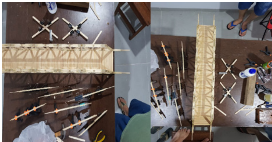
Figura 5. Confeção de partes das estruturas para construção da ponte.
