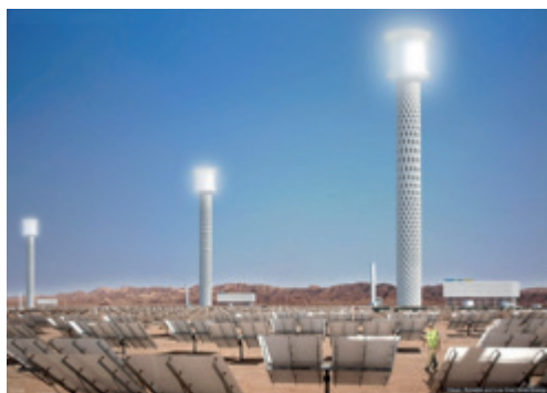
Figura 2. Concentrador tipo torre
