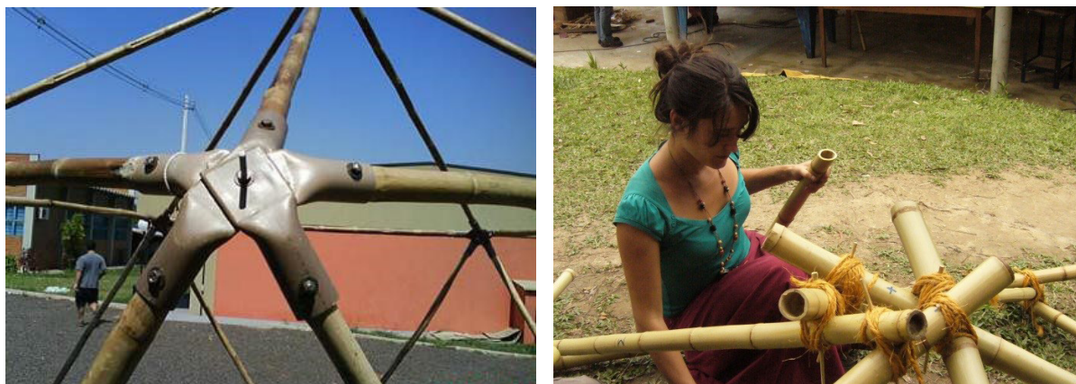
Figura 4. Conexão domo geodésico I (tubos de PVC parafusados) e II (amarrada com corda natural)
