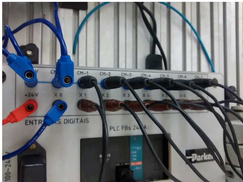
Figura 4. Ligação da fiação elétrica no CLP
