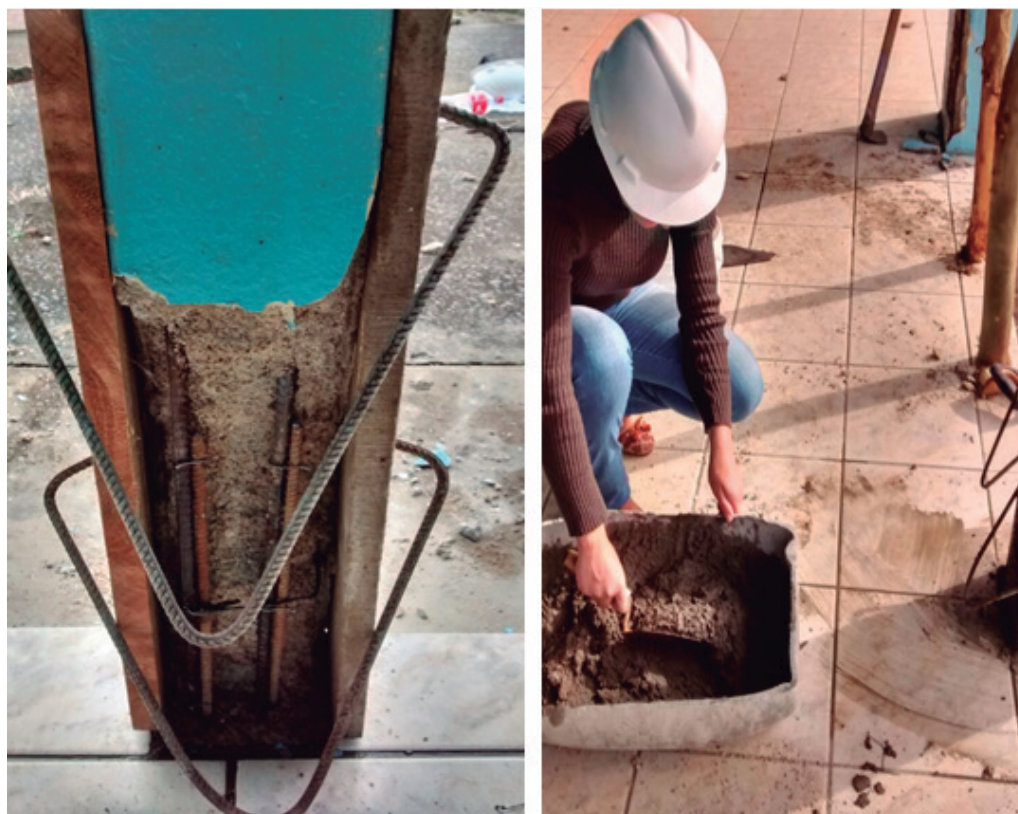
Figura 6. Colocação do concreto
