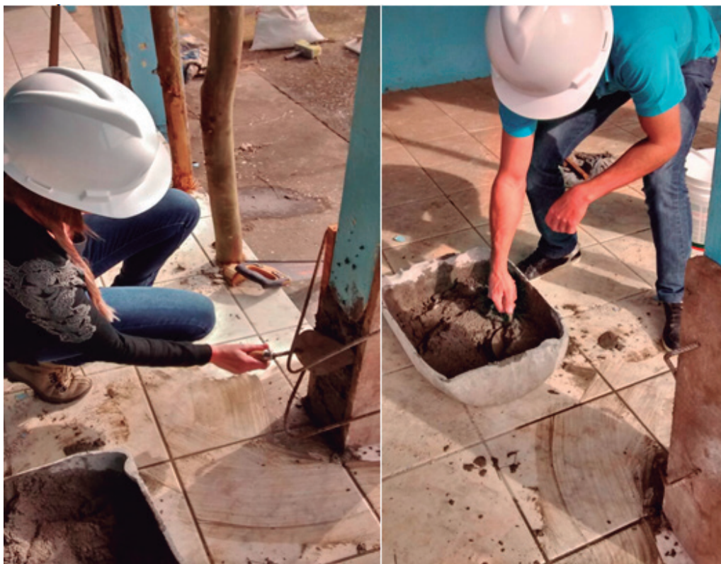
Figura 7. Colocação do concreto
