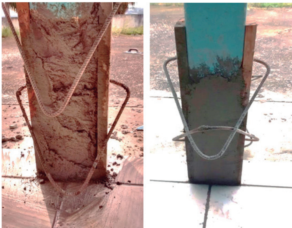
Figura 8. Colocação do concreto
