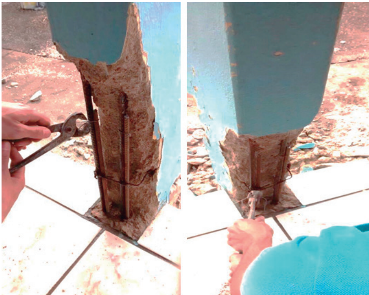
Figura 5. Colocação das barras de reforço
