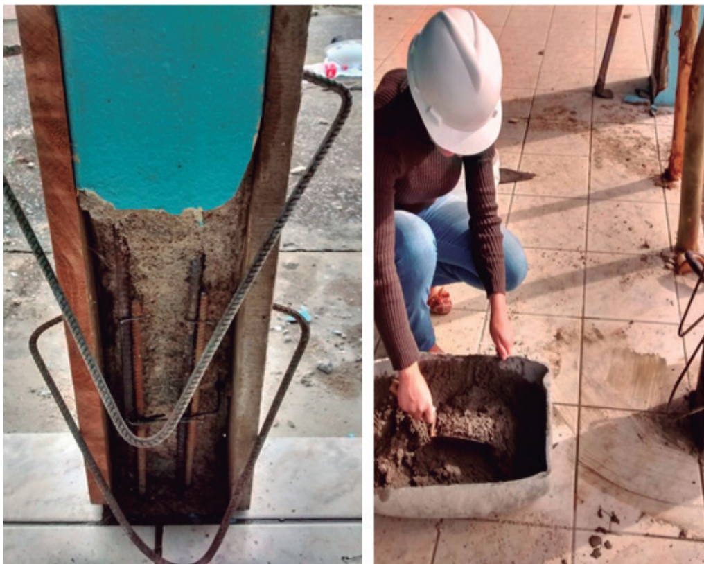
Figura 6. Colocação do concreto
