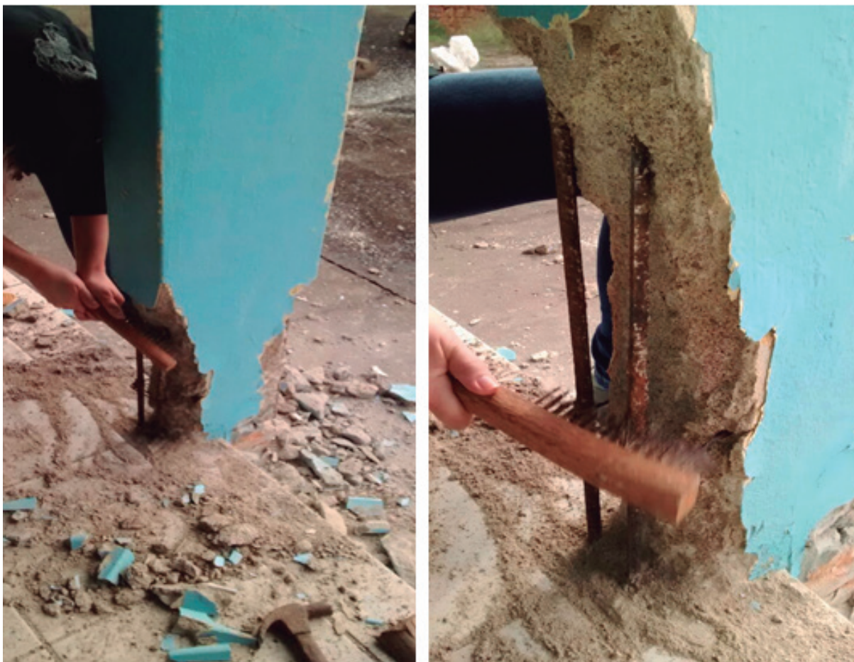
Figura 4. Limpeza das barras com escova de aço
