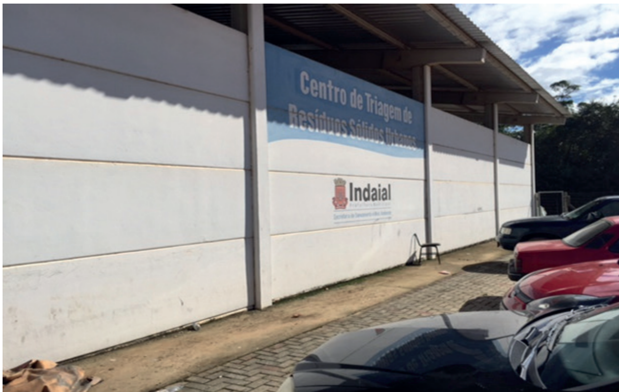
Figura 1. Fachada da APRI
