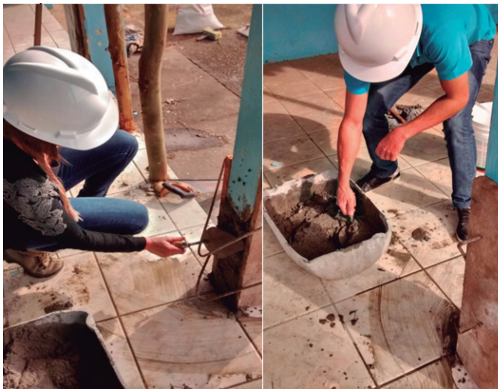
Figura 7. Colocação do concreto
